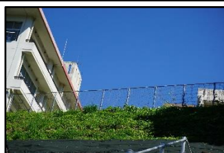
【保健室横のり面】
